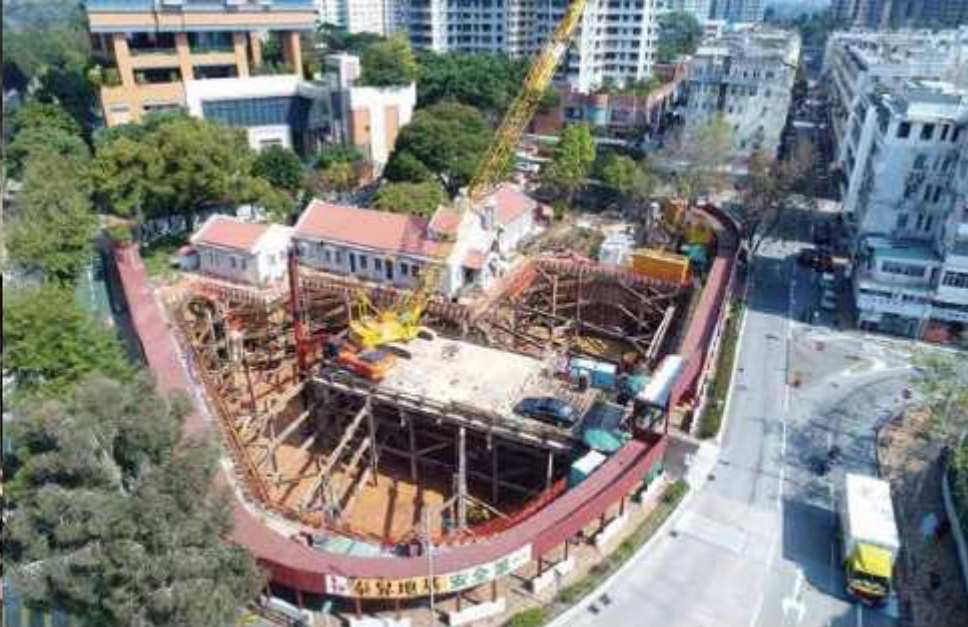
堂區擴建工程進行中
